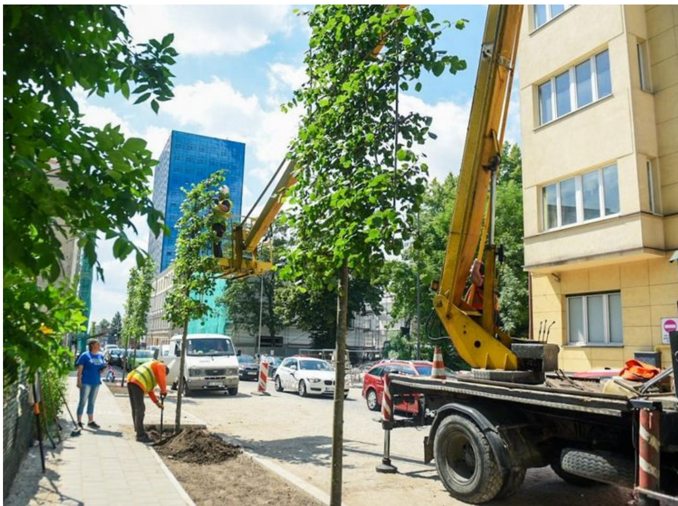
Modernizacja wodociągu na ul. Sienkiewicza dobiega końca. , fot. Paweł Łacheta / UMŁ
