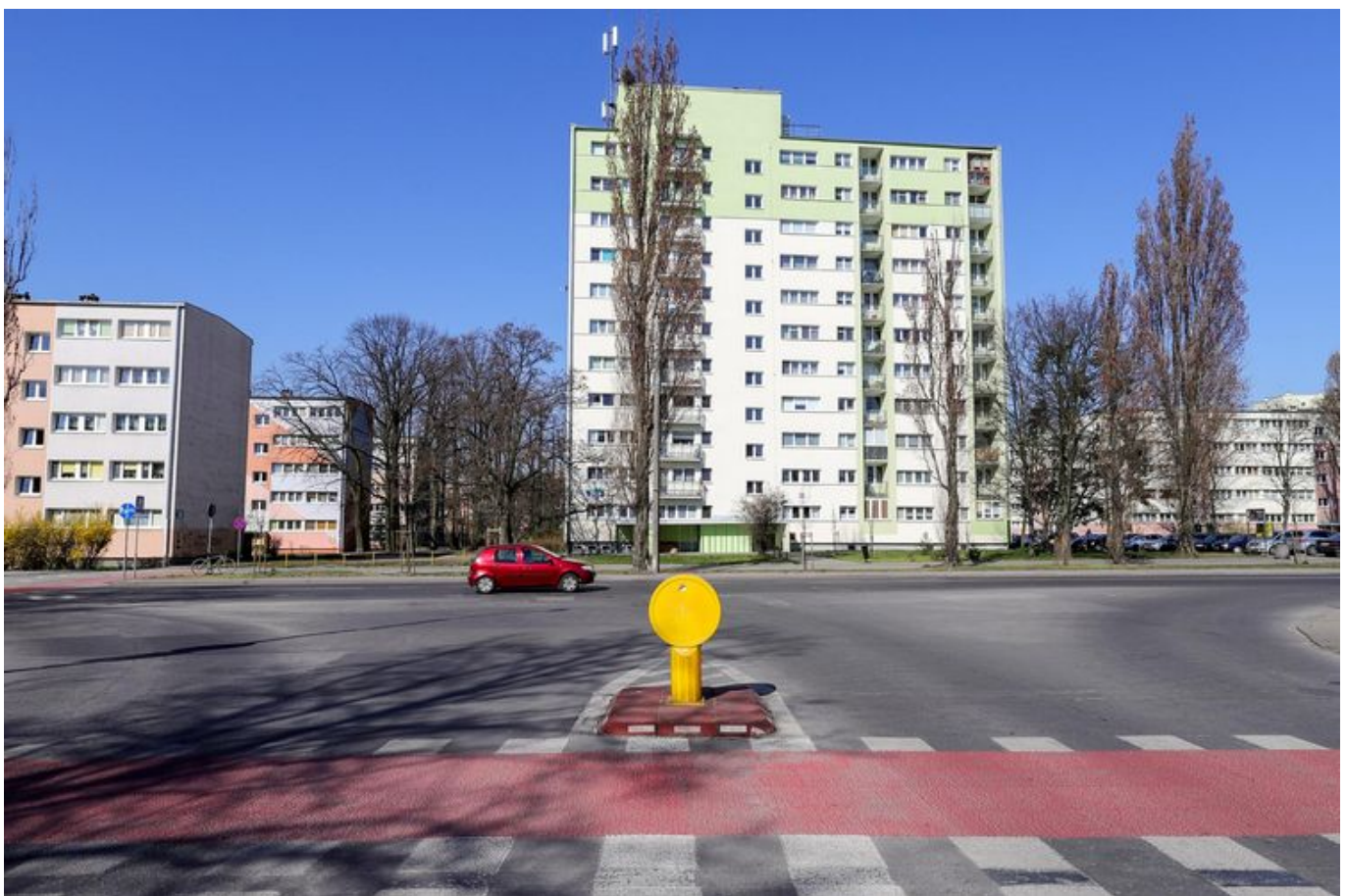
Miasto ogłosiło przetarg na wykonawcę modernizacji ul. Traktorowej. , fot. Konrad Ciężki / UMŁ
