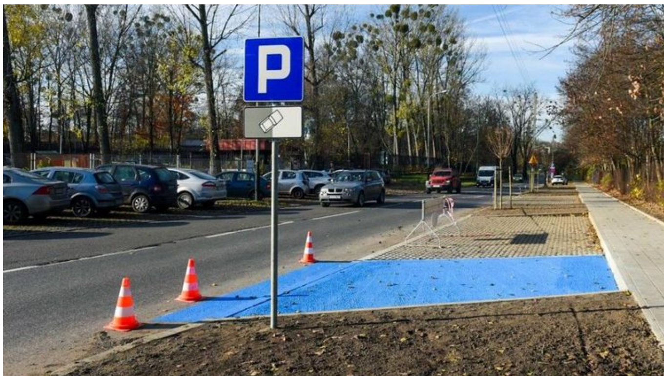
Przy ulicy Źródłowej między ulicami Smugową a Sporną powstały miejsca parkingowe oraz wybudowano chodniki , fot. UMŁ
