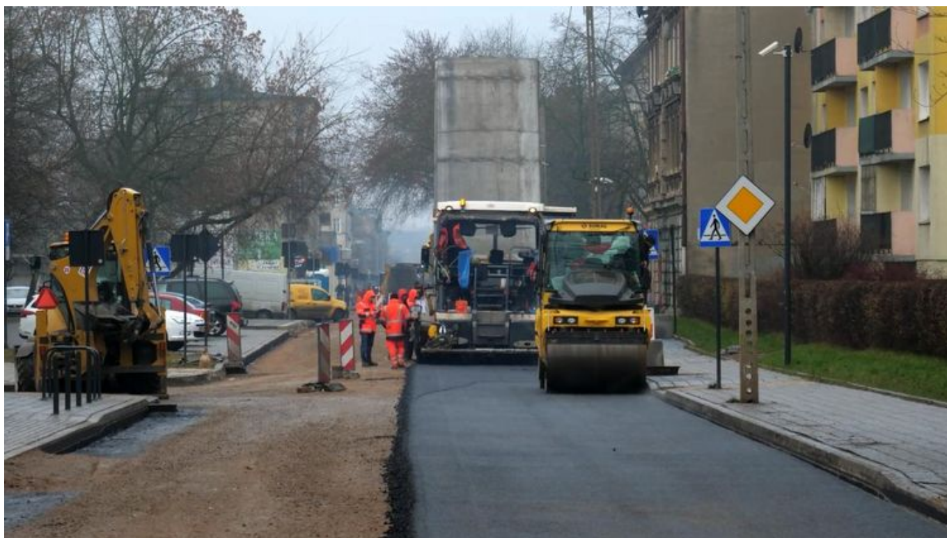
Na ulicy Zarzewskiej rozpoczęło się wylewanie asfaltu , mat. UMŁ
