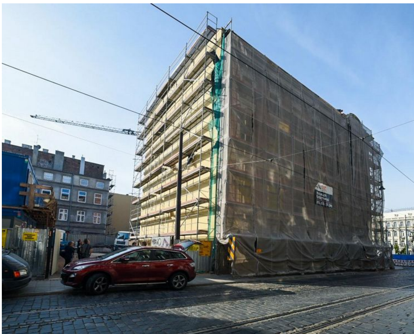
W kamienicy przy ul. Zielonej 6 trwają prace budowlane , fot. Paweł Łacheta / UMŁ
